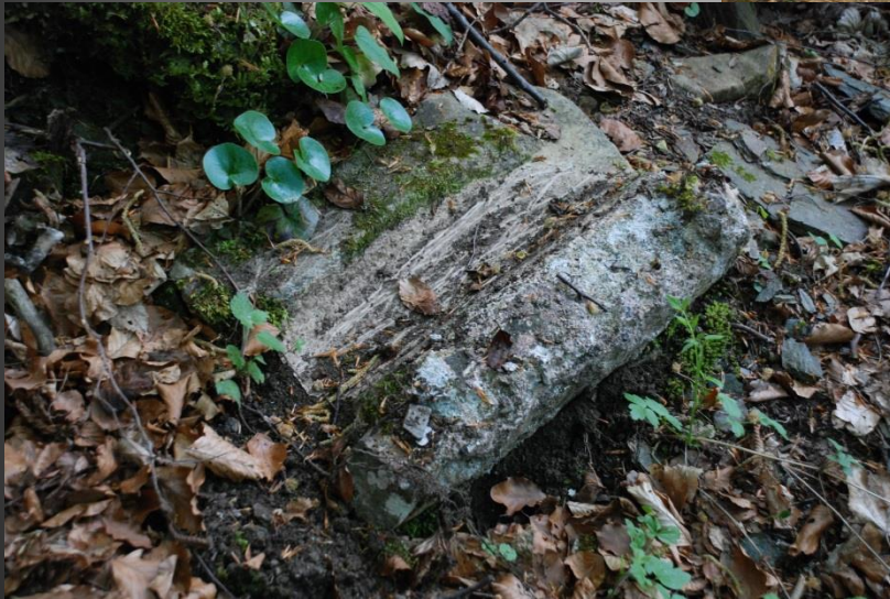
Водовод изнад Манастира Студенице
